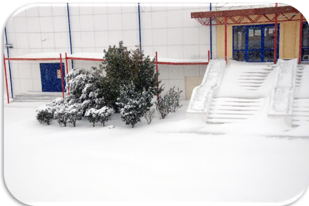
Εξωτερικός Χώρος της Σχολής
