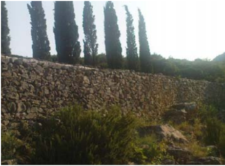
Εικόνα 28. Τοίχος αντιστήριξης στην περιοχή Κατουνάκια Άγιο Όρος.
