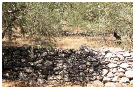
Εικόνα 2. Κανονικός τοίχος αντιστήριξης σε αναβαθμίδα με αργολιθοδομή.
