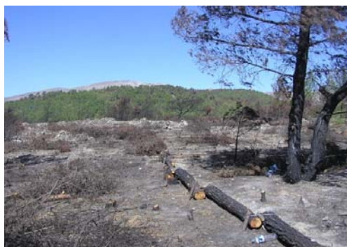
Εικόνα 1. Κατασκευή κορμοδεμάτων σε θέση με μικρή κλίση εδάφους. Figure 1. Log bales construction in position with small slope.
