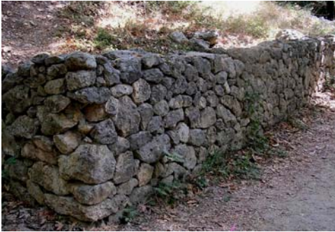
Εικόνα 37. Τοίχος αντιστήριξης με γωνία σε περιοχή της Λευκάδας. Figure 37. Retaining wall with an angle at an area of Lefkas.
