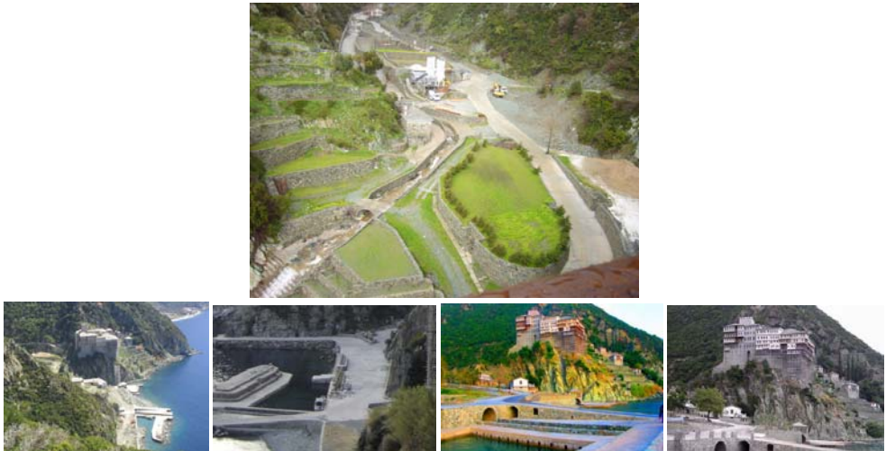
Εικόνα 13α,β. α) Τα υλοποιηθέντα έργα του αντιπλημμυρικού συστήματος διευθέτησης του Αεροπόταμου (έργα απόσβεσης) και β) ο τρόπος εκκένωσης του χειμάρρου στη θάλασσα.
