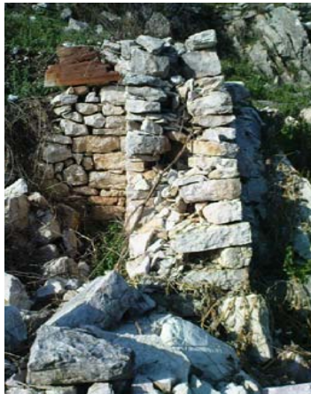
Εικόνα 36. Ξερολιθική κατασκευή τοίχου διπλής όψεως στην περιοχή Στριγάνια Αιτ/νίας.
