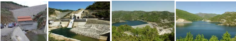
Εικόνα 6. Απόψεις α) του σώματος και β) του ταμιευτήρα του φράγματος Σισανίου.
