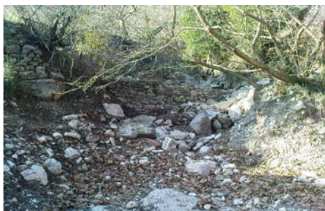
Εικόνα 1. Αργολιθοδομή για τη διευθέτηση χειμάρρων στο Λαμπίρι Θέρμου Αιτ/νίας.
