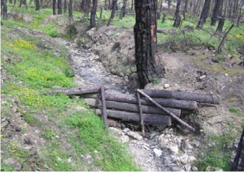
Εικόνα 5. Κατασκευή κορμοφράγματος σε υδάτινο ρεύμα 3 ης τάξης.
