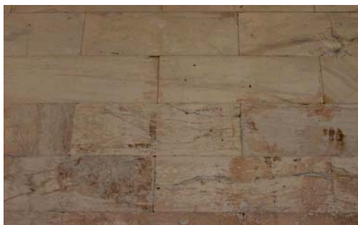
Εικόνα 10. Ισόδομη λαξευτή τοιχοποιία σε αρχαίο ελληνικό ναό. Figure 10. Equal-structured masonry at ancient Greek temple.
