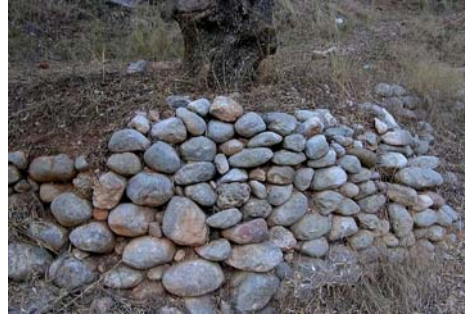
Εικόνα 25. Θύλακας υποστήριξης ελαιοδέντρου με κροκαλολιθοδομή, περιοχή Αμφισσας.
