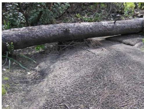
Εικόνα 3. Δημιουργία κενών μεταξύ εδάφους και κορμοδεμάτων. Figure 3. Creating gaps between the ground and the log bales.
