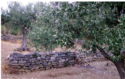
Εικόνα 4. Τοίχος αντιστήριξης με ημιλαξευτή λιθοδομή, περιοχή Μεσολογγίου.
