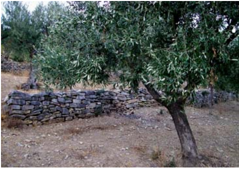
Εικόνα 13. Αντιστήριξη κάθετης πλευράς για συγκράτηση εδάφους σε καλλιέργεια ελιάς, Ρέτσινα Μεσολογγίου.
