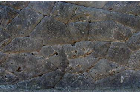
Εικόνα 8. Κυκλώπειας τοιχοποιίας αναλημματικός τοίχος με μικτής μορφής ημιλαξευτών λίθων.
