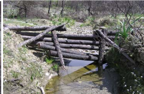
Εικόνα 8. Καταστροφή κορμοφράγματος λόγω κακής θεμελίωσης.
