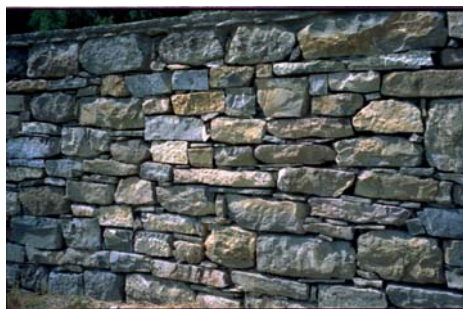
Εικόνα 5. Τοίχος αντιστήριξης με ημιλαξευτή λιθοδομή, Άγιο Όρος Κάρεις.
