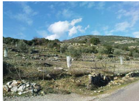
Εικόνα 31. Ελεύθεροι τοίχοι αντιστήριξης στο Λευκό Παραβόλας, η υψομετρική τους διαφορά δεν ξεπερνά τα 90 εκατοστά.
