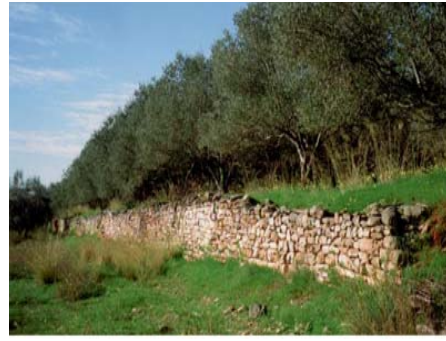
Εικόνα 29. Τοίχος αντιστήριξης σε ελαιώνα στη Παντάνασσα.
