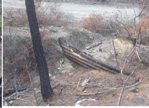
Εικόνα 6. Κατασκευή κορμοφράγματος σε κοίτη μεγάλους πλάτους.
