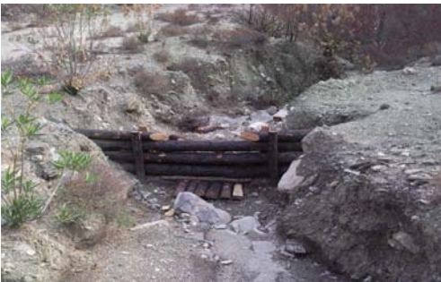
Εικόνα 7. Κατασκευή κορμοφράγματος σε θέση με χαλαρό εδαφικό υλικό.
