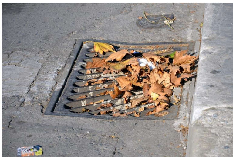
Εικόνα 22. Ανάγκη για καθαρισμό των φρεατίων.
