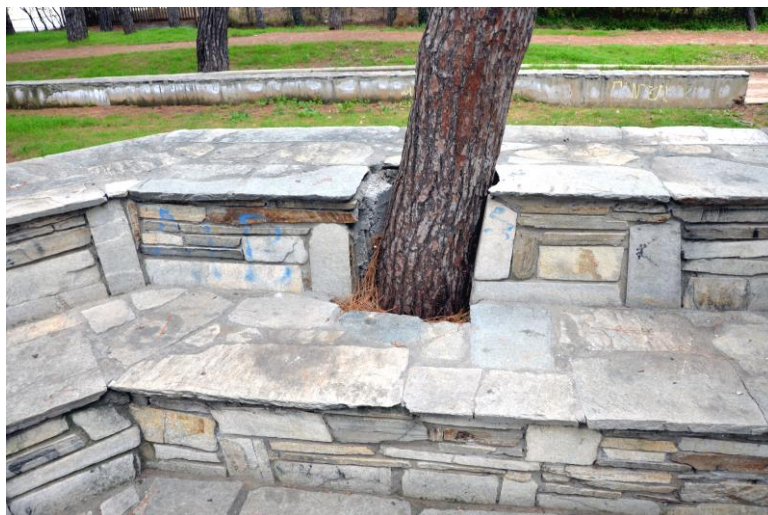
Εικόνα 18. Λάθος σχεδιασμός της θέσης κατασκευής του έργου.
