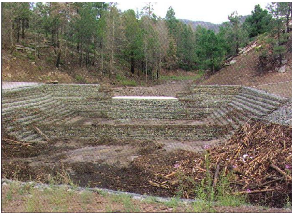
Σχήμα 11. Διάνοιξη χωμάτινων (α) συρματοπλεκτων τάφρων (β) για συγκράτηση νερού και φερτών
